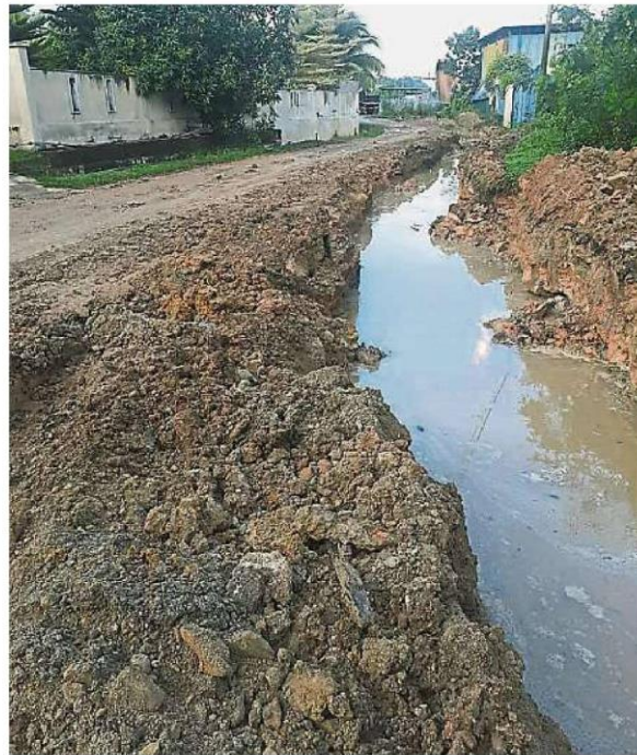
为了解决新村SJ 7路排水系统不胜负荷的问题, 蔡伟杰先动用了拨款挖出泥沟, 加速疏通大水。
